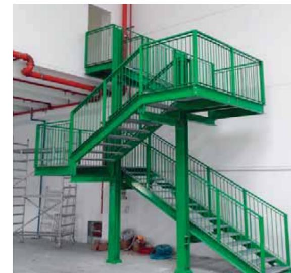
Le scale di sicurezza sono realizzate con strutture metalliche smontabili costruite e installate rispettando le normative sulla sicurezza. La finitura di superficie avviene tramite zincatura a caldo o trattamento di verniciatura a richiesta.
