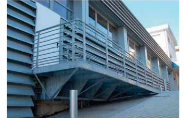
Le passerelle sono costruite con elementi metallici smontabili ad incastro o bullonate con luci libere a misura, zincate o verniciate, complete di parapetti di sicurezza laterali e piano di calpestio in grigliato o in altri materiali a richiesta.
